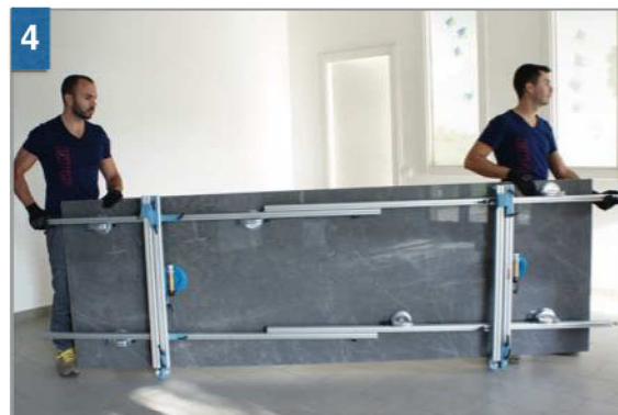
4 Trasportare la lastra (con KIT CARRELLO se disponibile). Transport the tile (with CARRIAGE KIT if available).
