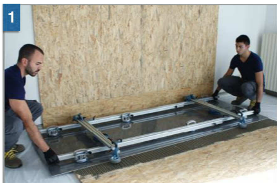
Posa a terra con telaio di movimentazione KERA-LIFT . Tiling the floor with the handling frame KERA-LIFT
