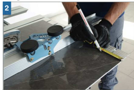
2 Segnare con una matita dove dovrà venire il taglio da ambo i lati della lastra. Mark with a pencil where the cut should come on both sides of the tile.
