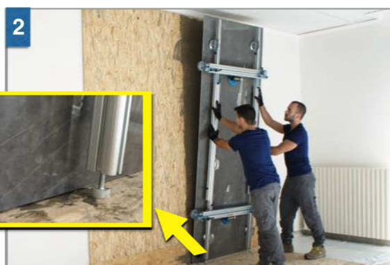
Durante la posa a parete i piedini d'appoggio del KERA-LIFT eviteranno danni alla lastra. During the fixing on the wall the support feet of the KERA-LIFT will avoid damage to the tile.
